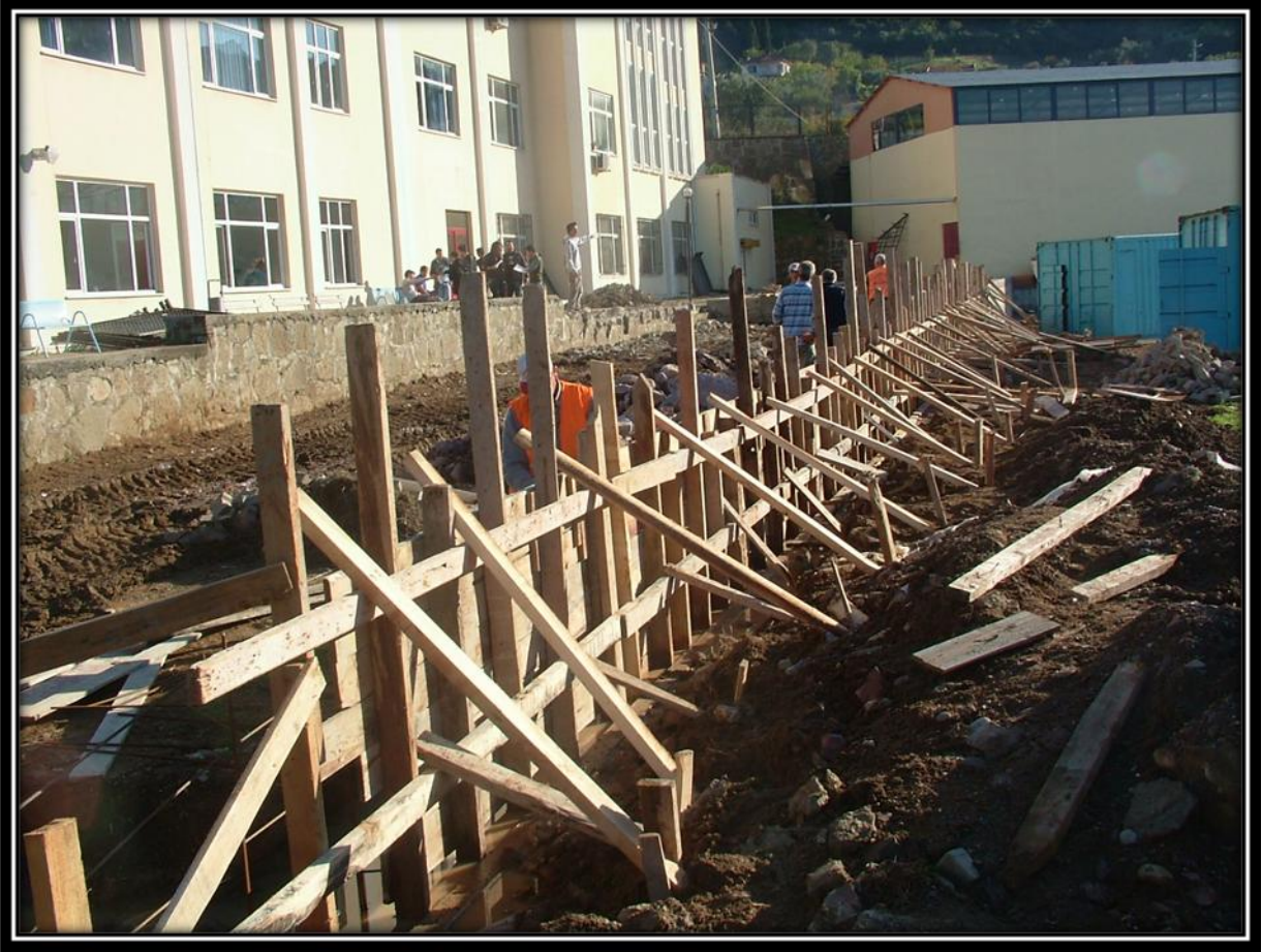
Kocaeli Üniversitesi Gazanfer Bilge Yüksek Okulu duvar yapımı çalışması
