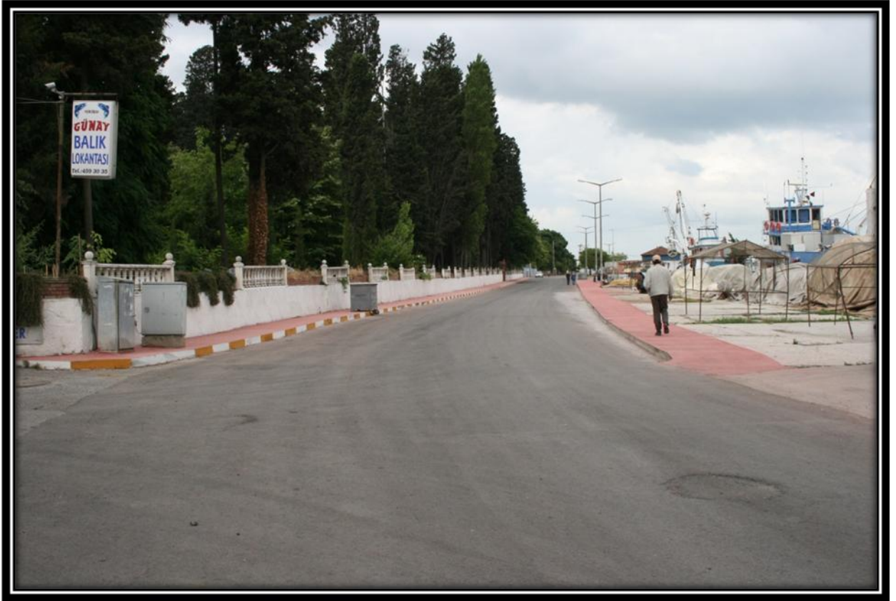
Ereğli Mahallesi asfalt yol düzenleme çalışması
