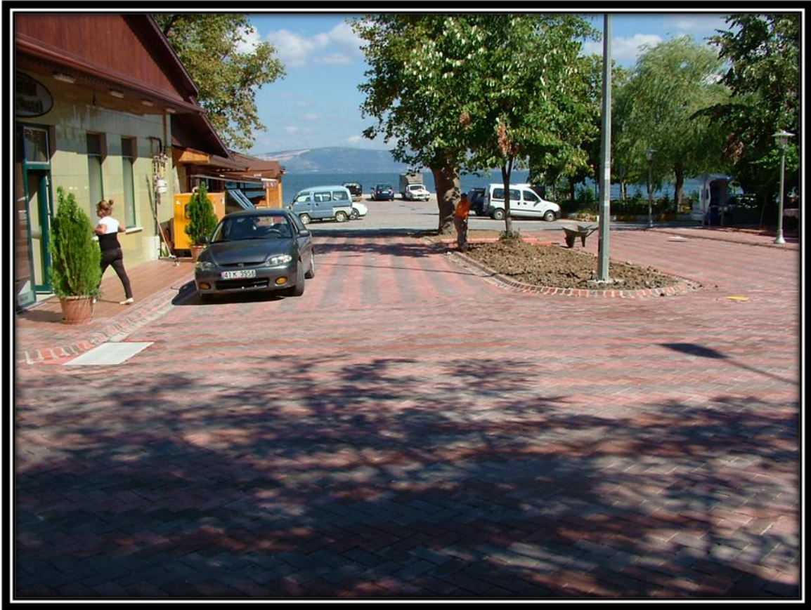
Ereğli Mahallesi parke taÇı alan düzenleme çalışması.
