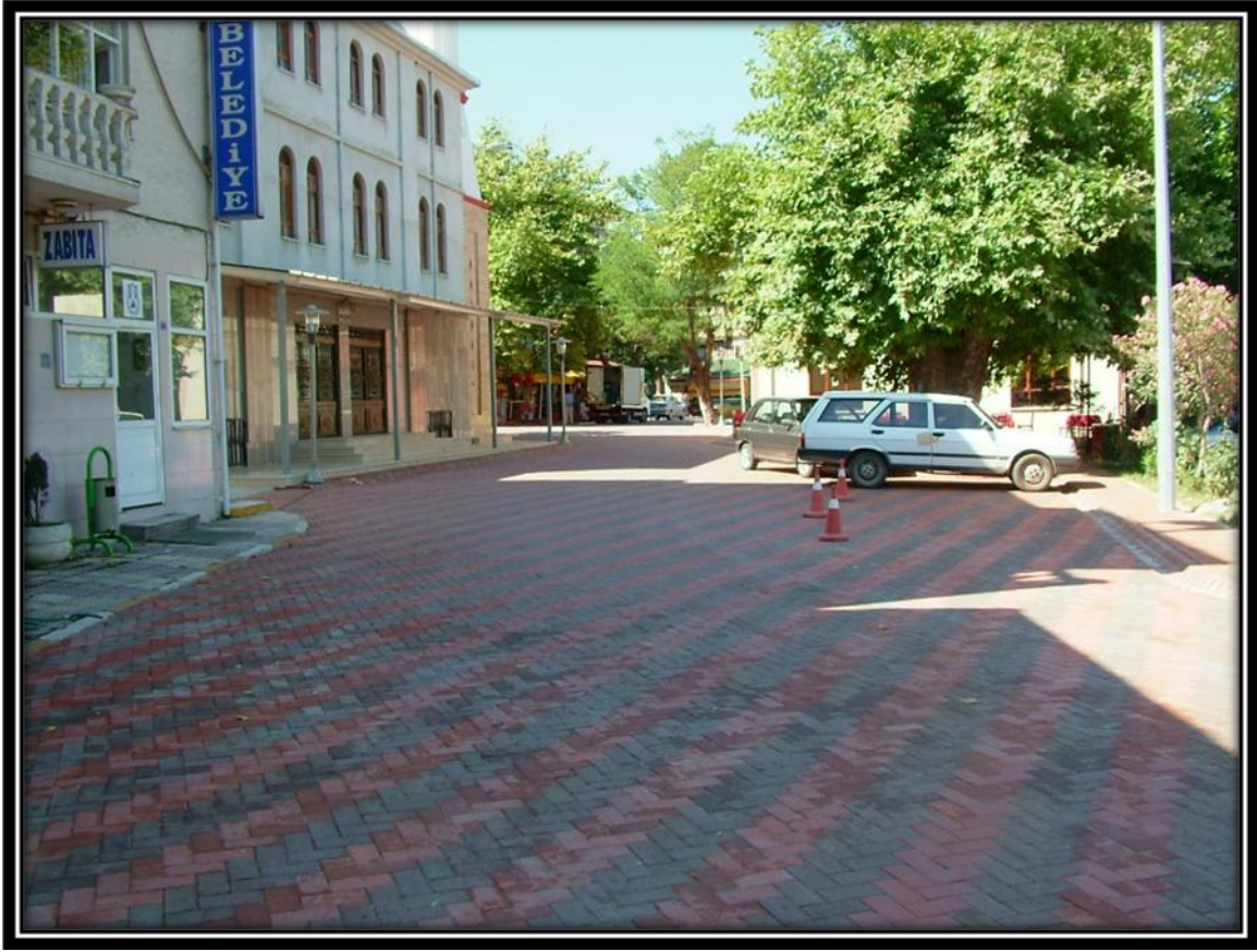
Ereğli Mahallemizden parke taÇı alan düzenleme çalışması.
