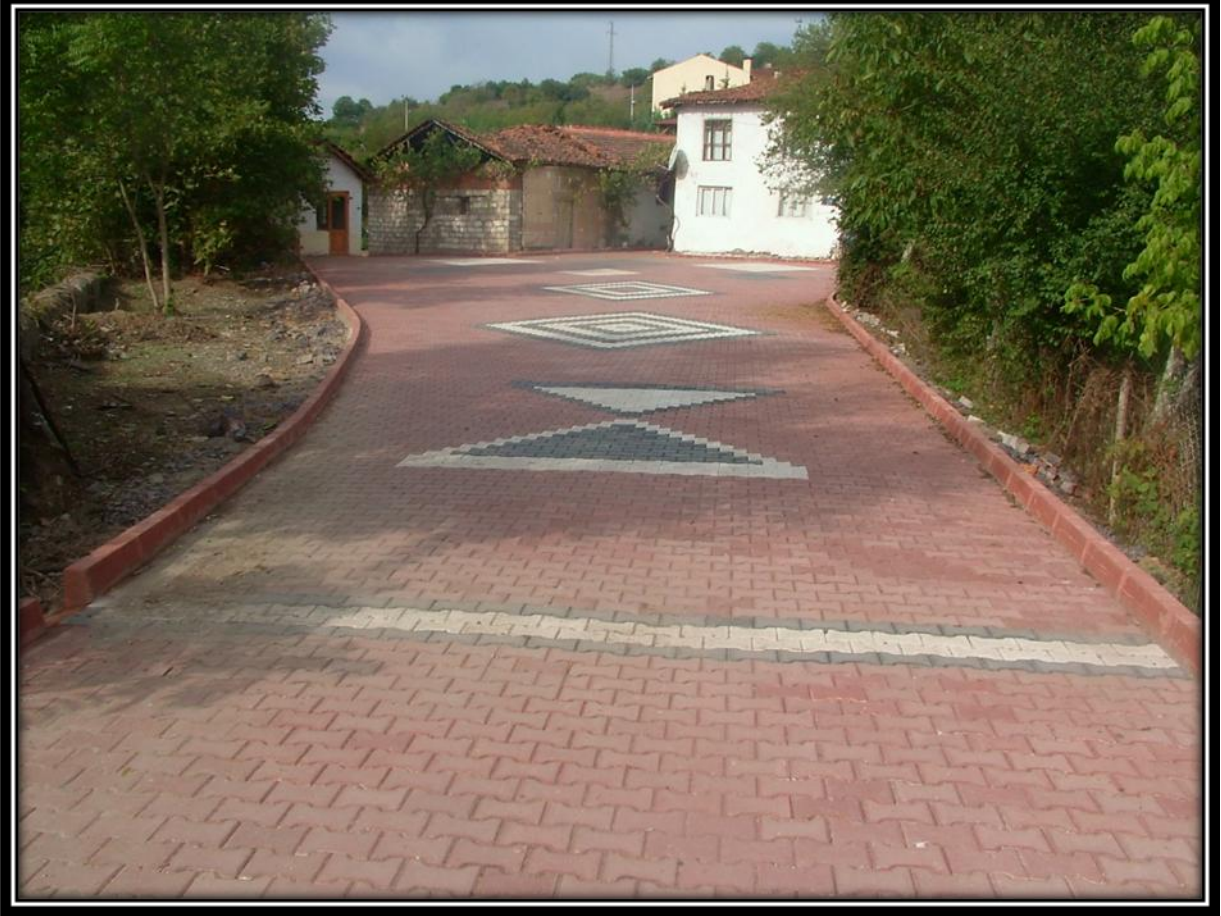
Yalakdere Mahallesi kilitli parke sokak düzenleme çalışması.
