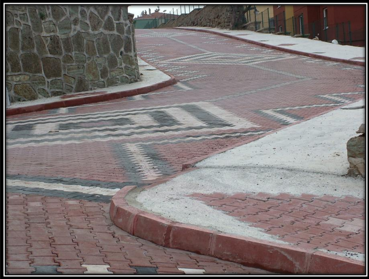
Eskonut civarında desenli parke yol çalışması
