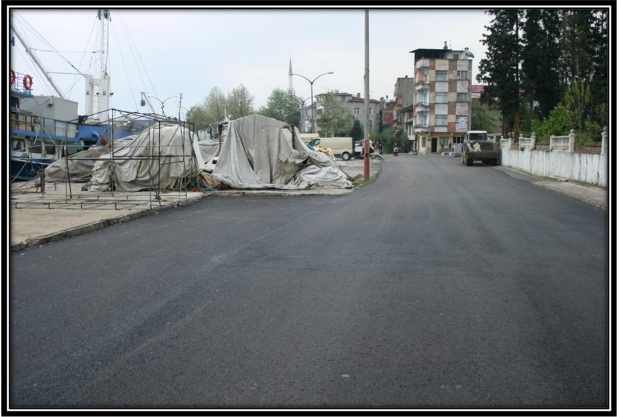
Ereğli Mahallesi asfalt yol düzenleme çalışması
