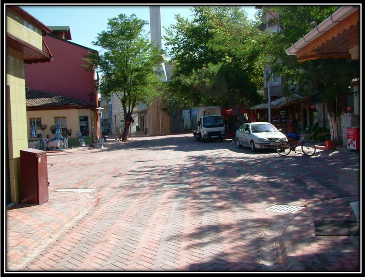
Ereğli Mahallesi parke taşı alan düzenleme çalışması
