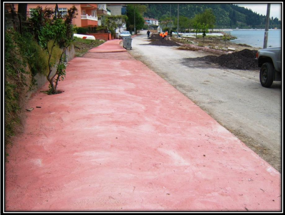
Defne sahil yolu yaya kaldırım düzenleme çalışması.
